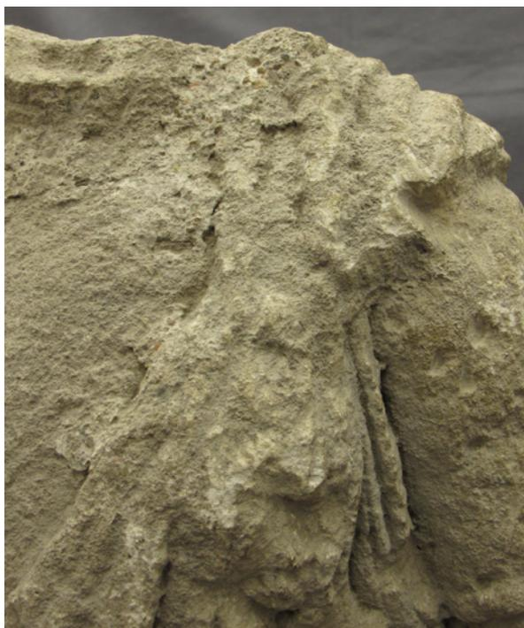
**Fig. 5.** Détails des mortiers recouvrant la face antérieure.
